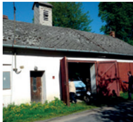
Svojanov - rekonstrukce střechy hasič. zbrojnice
