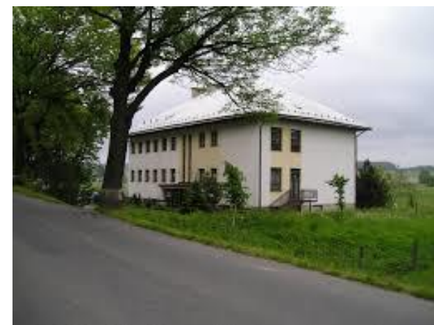
Stav před realizací
