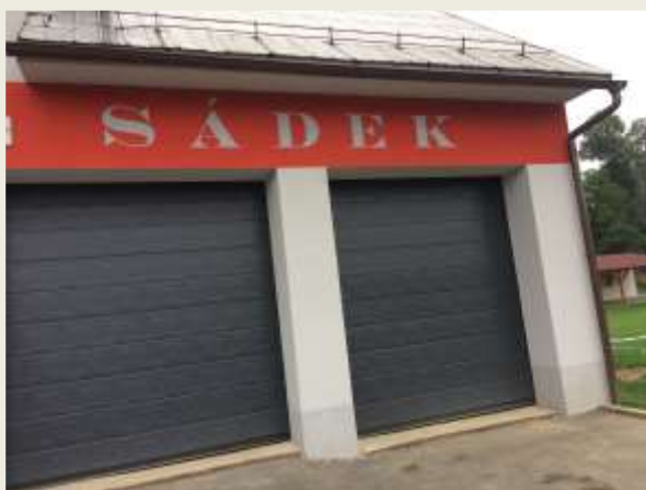
Obec Sádek – Výměna klempířských prvků na has. zbrojnici
