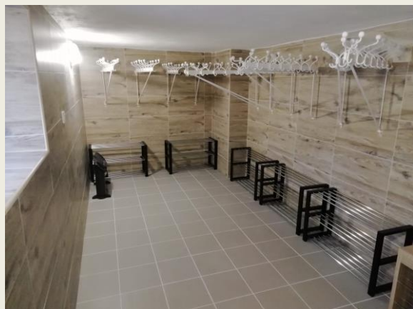
Oprava šatny v kulturním domě Nedvězí
