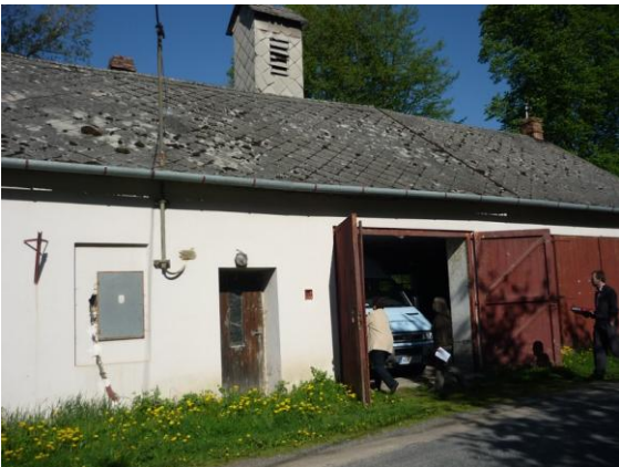
Svojanov – rekonstrukce střechy hasič. Zbrojnice
